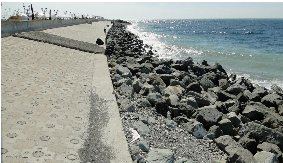
Рисунок 5 – Устройство каменно-набросной бермы для защиты ростверка и бетонного откоса набережной
