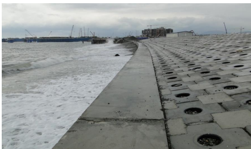
Рисунок 1 – Размыв галечного пляжа после возведения порта
