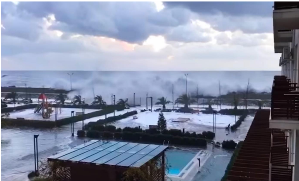
Рисунок 3 – Перелив волн через берегозащитные сооружения
